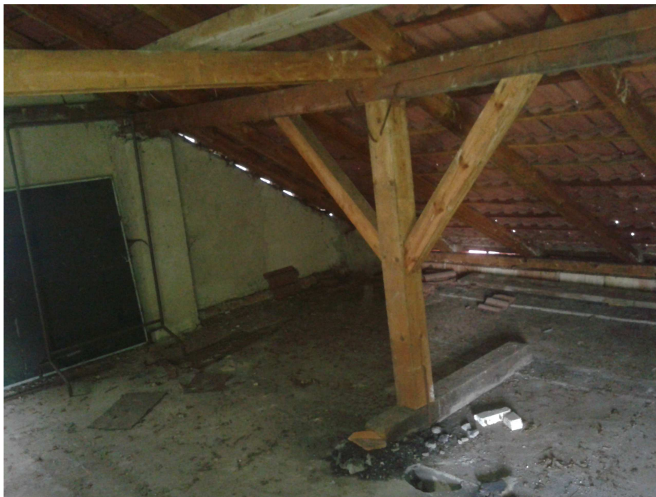
Obr.4 - Krov je podepřen sloupkem a přes bačkuru je zatížení nerovnoměrně rozneseno na dva stropní nosníky, zdivo štítu je pod uložením střední vaznice zesíleno pilířkem
