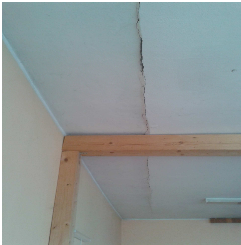
Obr.2 - První krajní nosník ,podél kterého je spára utrženého pole desek, které leží i na stěně
