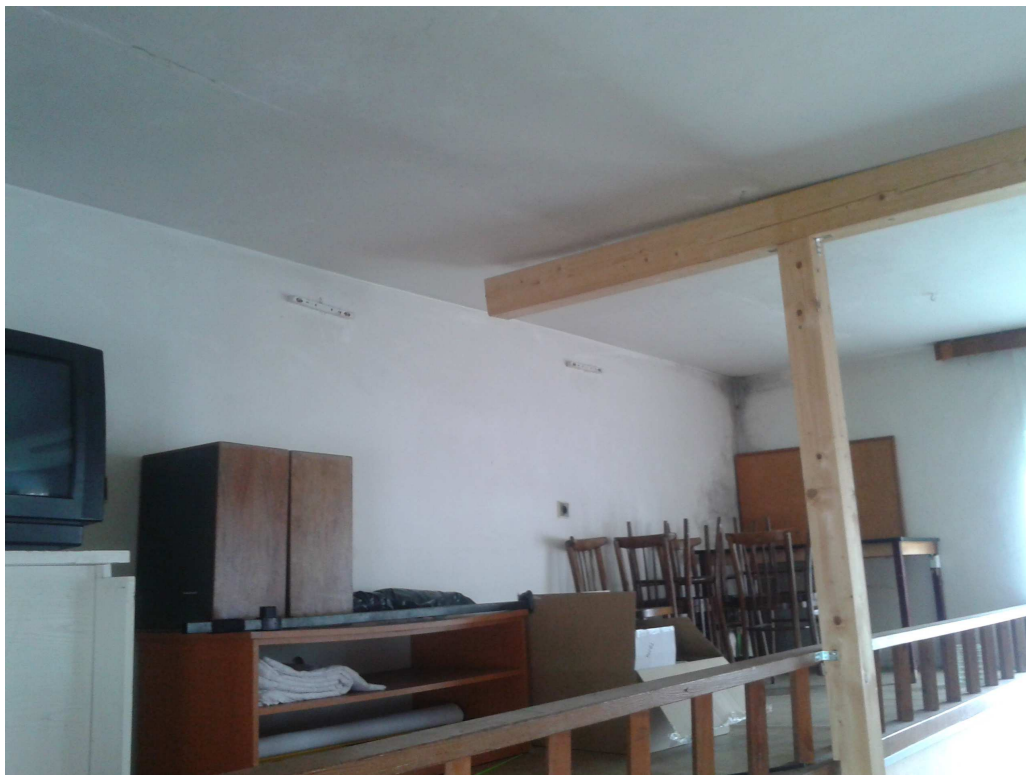
Obr.3 - Na podepření stropu je vidět nadměrný průhyb
