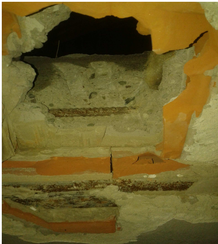
Obr.1- Sonda do stropní konstrukce – patky, spodní příruba nosníku, podélná výztuž obetonování
